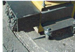
Préparer et nettoyer fissures, parties de routes abimées, nids-de-poule pour la pose d'asphalte froide
