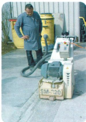
Correction rapide d'une surface en béton
